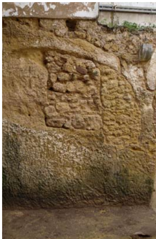
Perspetiva do arco escavado na rocha, respetivos entaipamentos e motivo cruciforme (S.P. 1).
