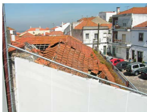
Cobertura em estado de ruína
