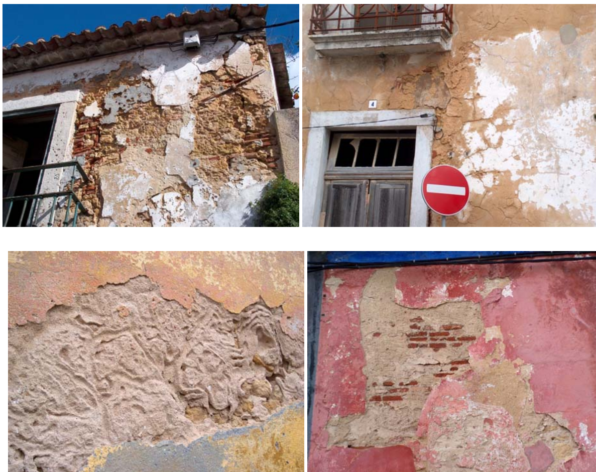
Fig. 4 – Descolamentos, destacamentos, perda de coesão, desagregação
