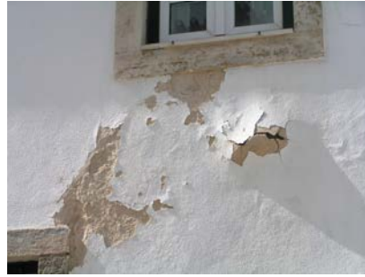
Falta de adesão e "colapso" do reboco
