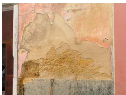
Falta de adesão
