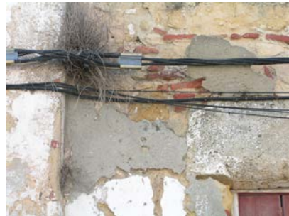
Reparações em cimento na fachada
