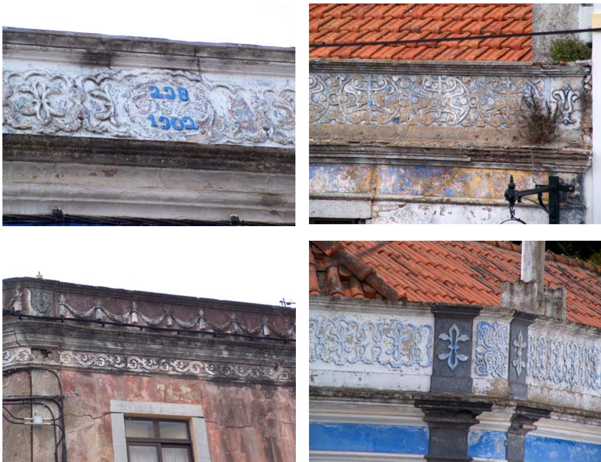
Fig. 17 – Alguns exemplos de elementos decorativos a preservar nos edifícios do Centro Histórico de Palmela
