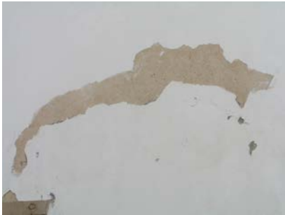
Falta de coesão
