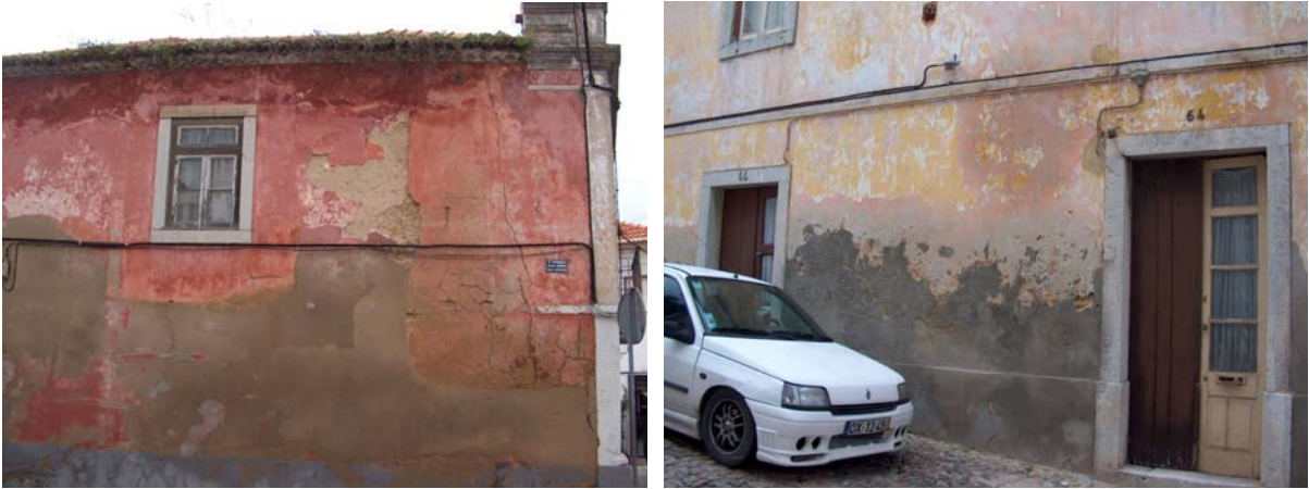
Fig. 2 – Exemplos de intervenções com argamassas de cimento em zonas afectadas pela humidade ascendente
