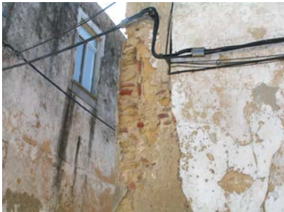
Lacuna do revestimento
