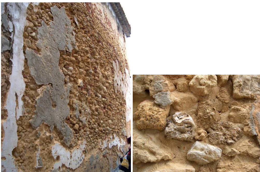
Fig. 1 – Zonas expostas das alvenarias antigas deixam visíveis a presença de conchas e búzios na argamassa de enchimento
