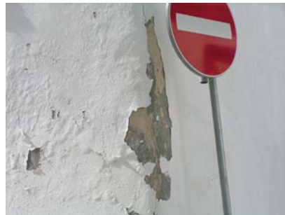
Reparações em cimento
