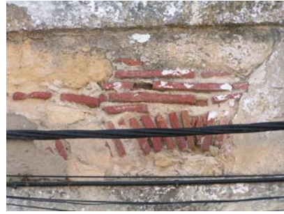
Falta de reboco
