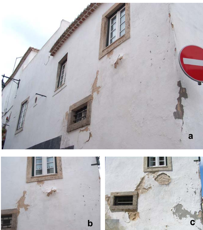
Fig. 6 – Edifício 4. Degradação progressiva do revestimento a) e b) em Dezembro de 2006; c) em Junho de 2007
