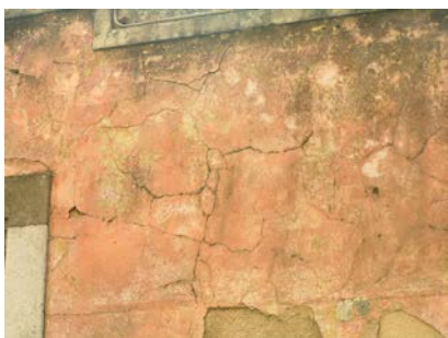
Fissuração do revestimento
