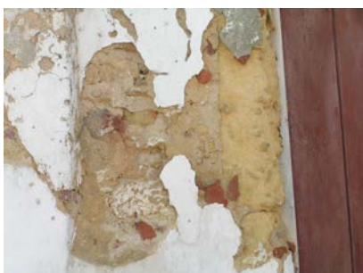
Falta de coesão
