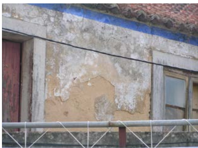
Destacamento de camadas de revestimento
