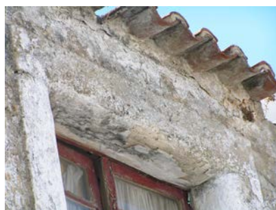
Falta de adesão
