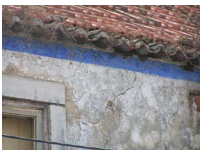
Fissuração do revestimento
