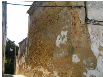
Lacuna do revestimento - fachada Sul
