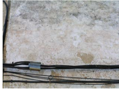
Fissuração do revestimento
