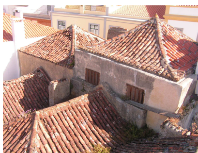
Foto 3 - Telhados de Tesouro
